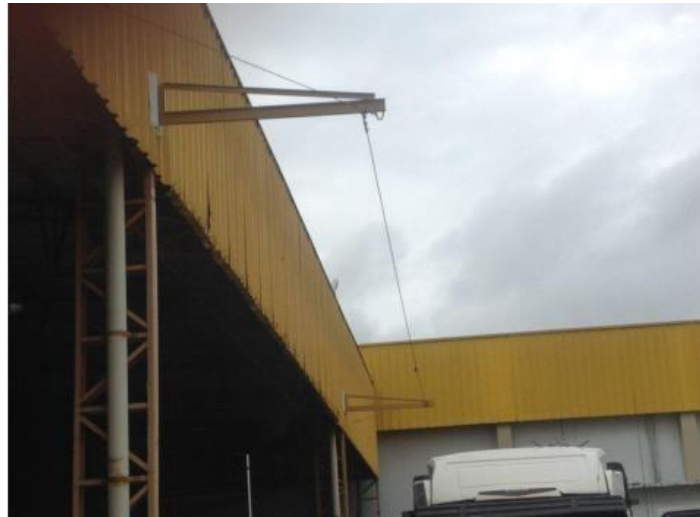
Figura 3: Linha de vida horizontal fixa
