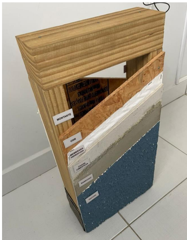
Figura 3. Composição da estrutura de wood frame.
