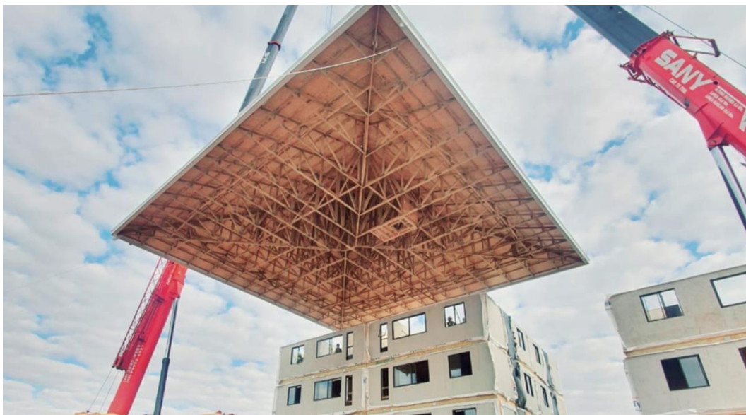
Figura 5. Instalação de telhado com utilização de guindaste.
