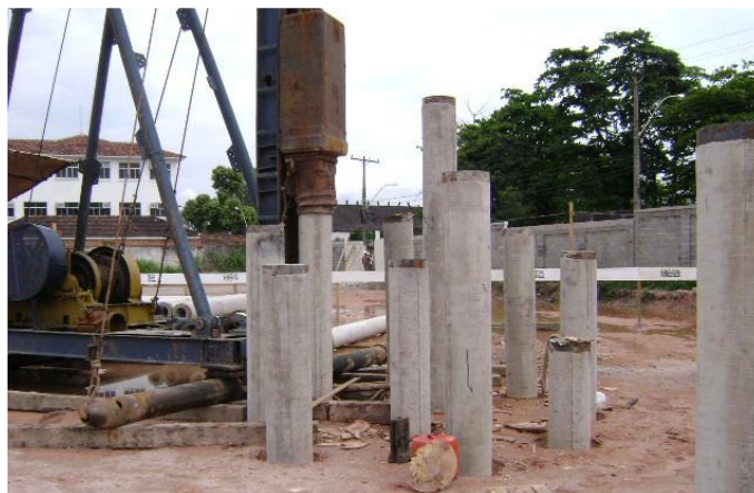
FIGURA 03 – ESTACA CRAVADA DE CONCRETO
