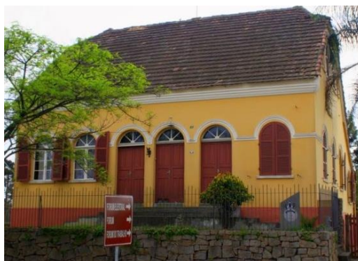
FIGURA 5 – A CASA DO CAVALO BAILO, TOMBADA PELO PATRIMÔNIO FEDERAL FONTE: JERA, 2018.
