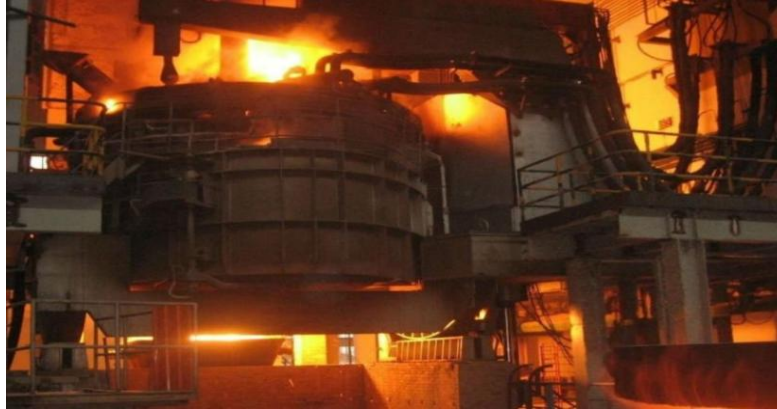
FIGURA 1 - FORNO ELÉTRICO A ARCO (FEA) VISTA POSTERIOR FONTE: HTTP://PORTUGUESE.ALIBABA.COM/PRODUCT-GS/TIEQI-MINI-STEEL-PLANT-ELECTRIC-ARC-FURNACE-FOR-SALE-626607812.HTML (2013)
