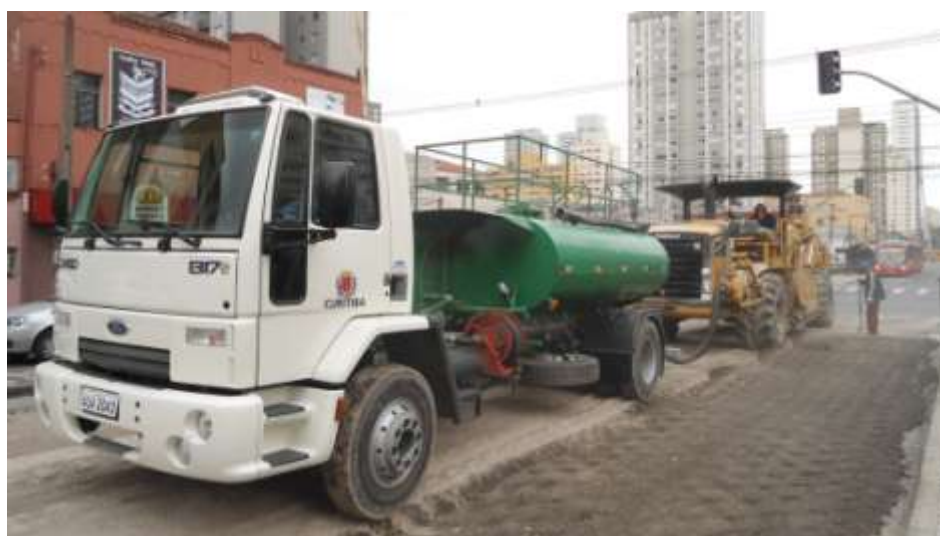
FIGURA 19 – MISTURA E ADIÇÃO DE ÁGUA FONTE: OS AUTORES
