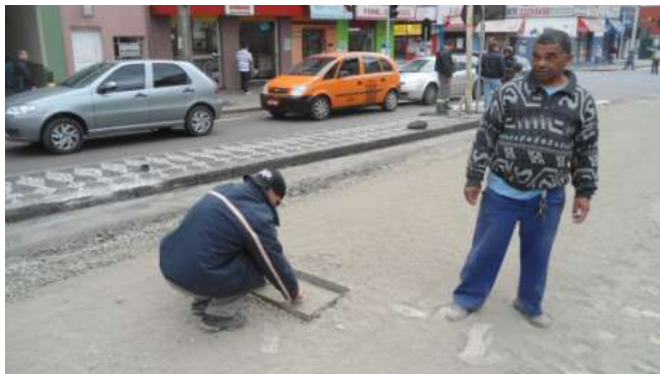
FIGURA 18 – CONTROLE DA TAXA DE APLICAÇÃO DO AGLUTINANTE (CIMENTO) FONTE: OS AUTORES
