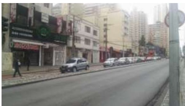
FIGURA 25 – LEVANTAMENTO VISUAL (III) DE DEFEITOS FONTE: OS AUTORES
