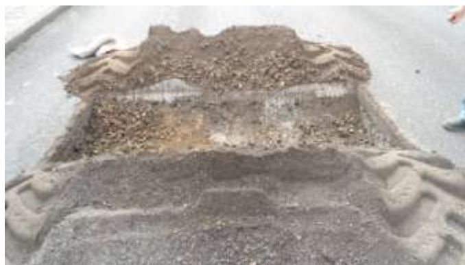
FIGURA 13 – HORIZONTES DA CAMADA DO PAVIMENTO FONTE: OS AUTORES
