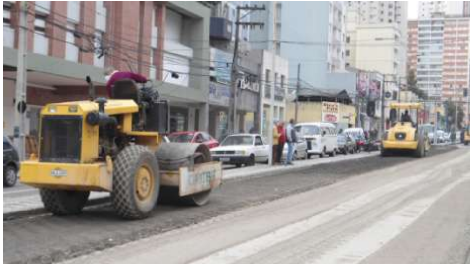
FIGURA 20 – COMPACTAÇÃO FONTE: OS AUTORES
