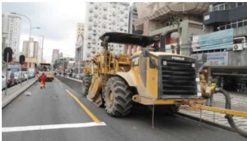
FIGURA 14 – EQUIPAMENTO PARA FRESAGEM FONTE: OS AUTORES
