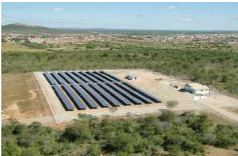
FIGURA 04: CENTRAL FOTOVOLTAICA DE TAUÁ / CE FONTE: MPX (2013)
